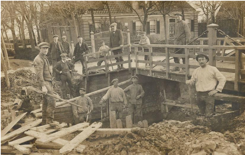
Eind jaren 20: er wordt gewerkt aan de brug naar de gasfabriek met op de achtergrond de stomp van Paarlberg aan de Oudewal 31.
